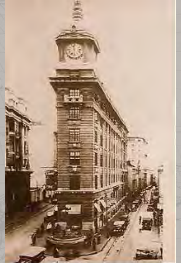
Dans le bas Valparaíso, l'immeuble Edwards sépare les rues Prat et Cochrane (début du XX e siècle)
